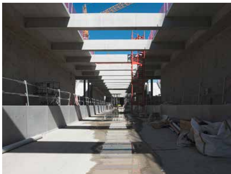
Halte de CHÊNE-BOURG - Fin des travaux de génie civil
