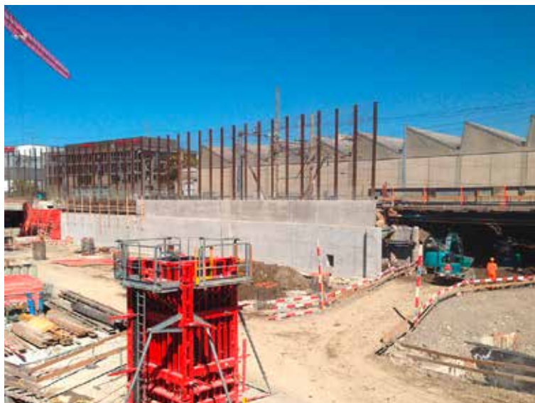
Gare de LANCY – PONT-ROUGE - Réalisation du passage sous voie principal
