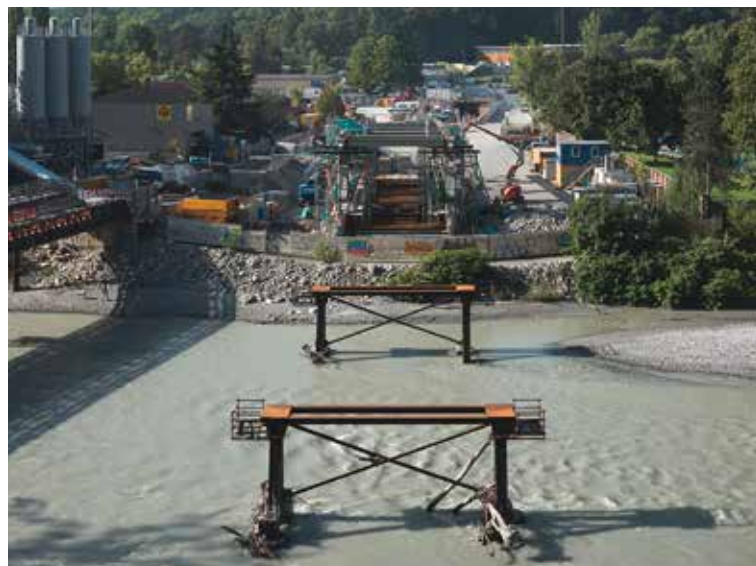
VAL D'ARVE - Pont sur l'Arve en cours d'assemblage sur la rive gauche
