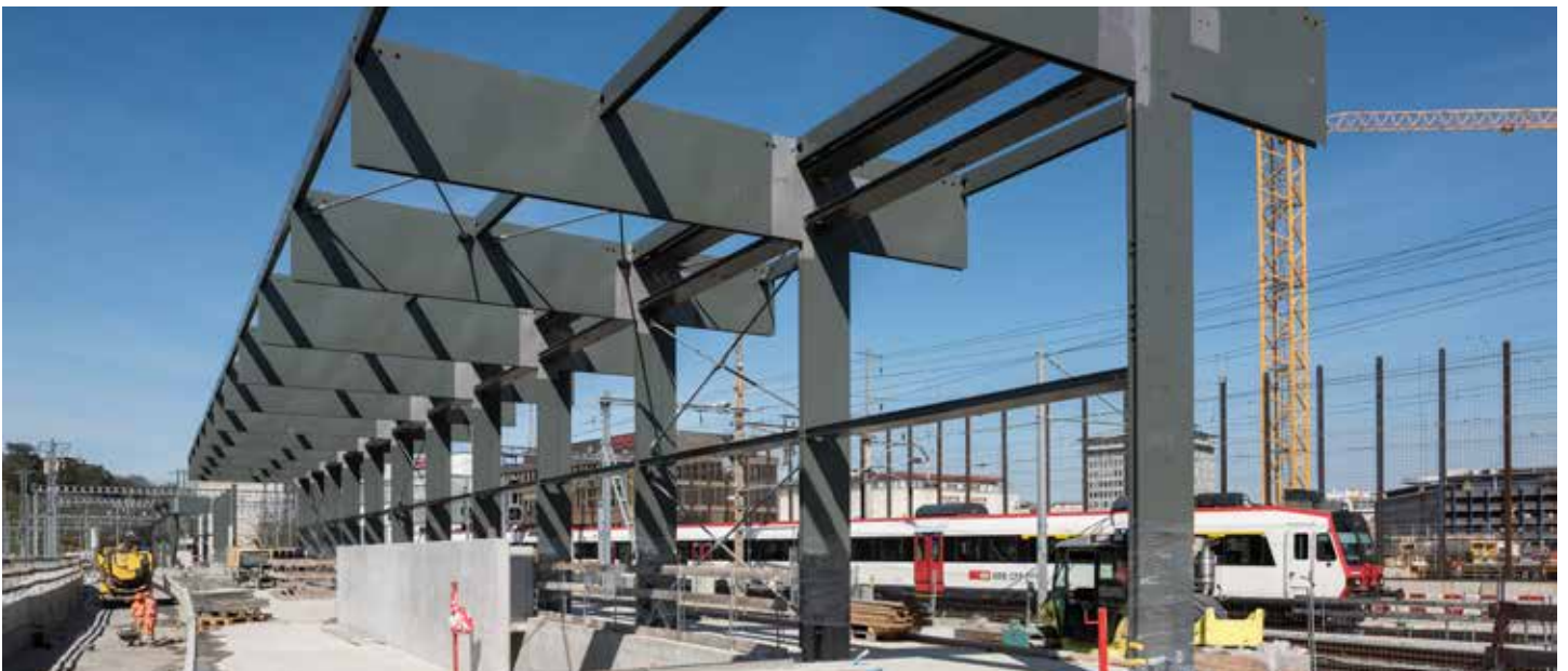
LANCY-PONT-ROUGE – Sa charpente métallique achevée, la station de Lancy – Pont-Rouge attend ses briques de verre.
